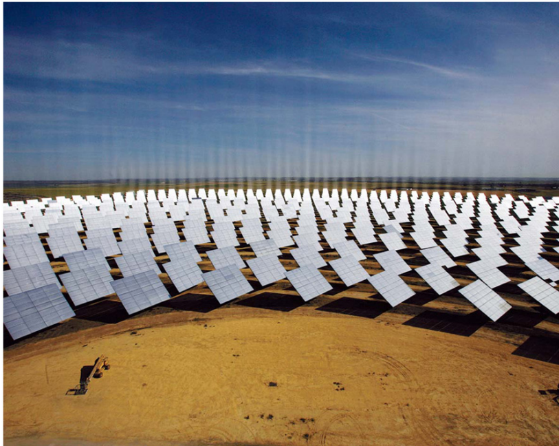
스페인의 아벤고아(Abengoa)사는 최근 타워를 이용한 상업용 태양력 발전소 'PS10'을 스페인의 남부도시 산루카르 라 마요르에 건립했다.
